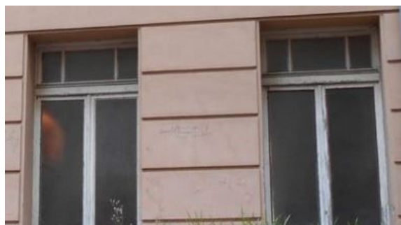
Figura 2.1 - Particolare dei serramenti – vista dall'esterno
