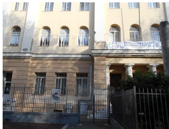
Figura 1.1 - Particolare della facciata principale
