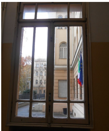
Figura 2.2 - Particolare dei serramenti – vista dall'interno
